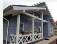
Эффект дыхания стен
